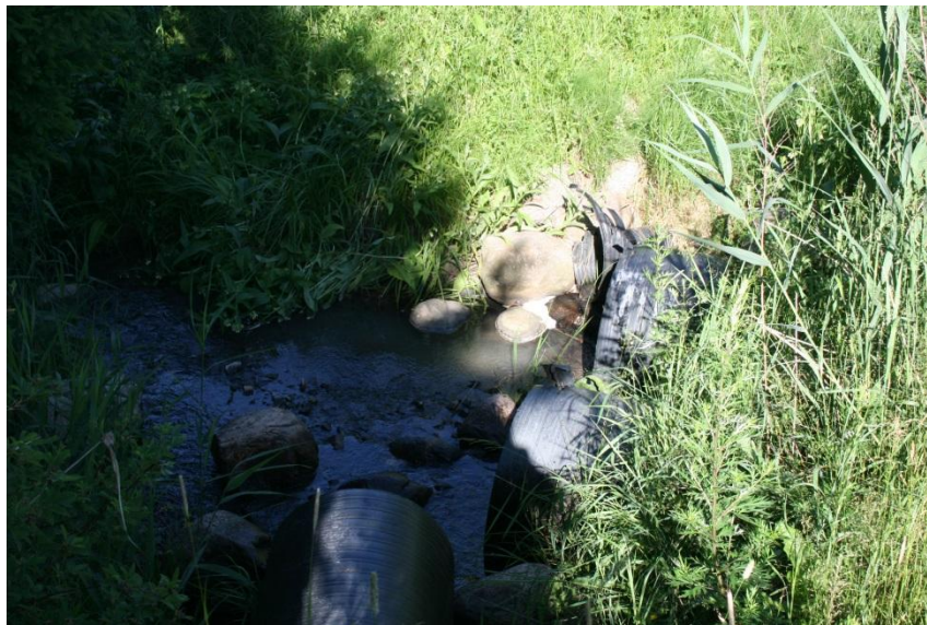
Kuva 133. Uomalaaksoon purkaa lukuisia isojakin hulevesiputkia.
