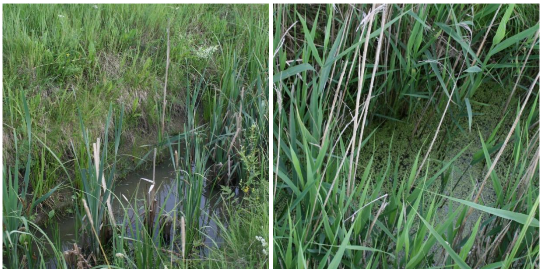
Kuva 123. Ojissa on penkkaeroosiota ja runsasta kasvillisuutta.
