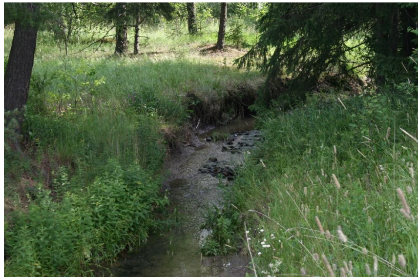
Kuva 81. Kuskinpolun rummun jälkeen uoman penkka on sortunut ja uomaan on penkalta valunut kiveä ja muuta sekalaista maalajia.
