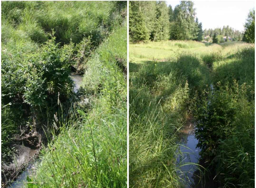
Kuva 99. Uoma on paikoin erodoitunut puistoalueella.
