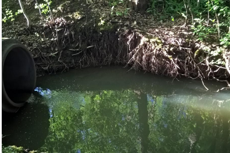
Kuva 137. Pientä noroa on kuormitettu hulevesillä ja se on aiheuttanut mittavaa eroosiota.
