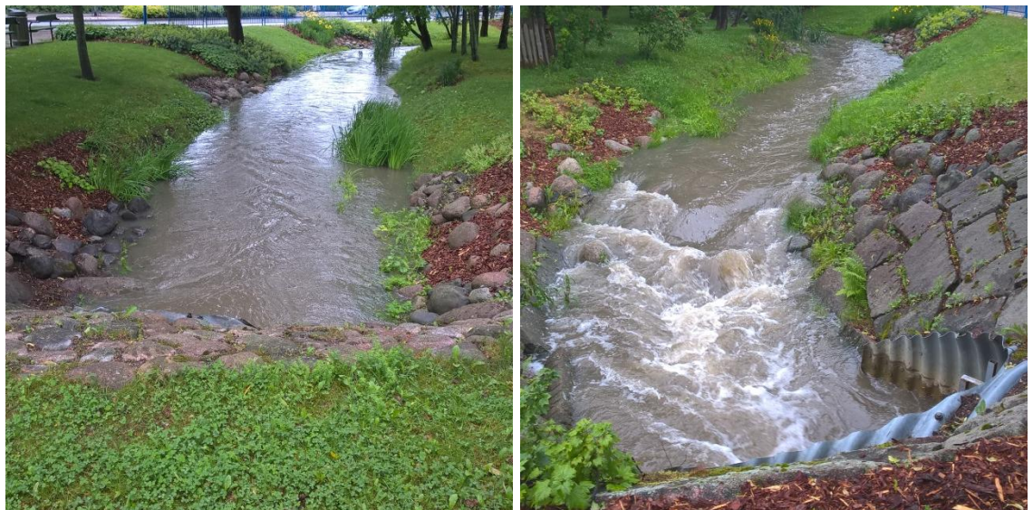
Kuva 68. Loutinoja virtaa vielä Mannilantien lounaispuolelta jonkin matkaa puistoalueella, kunnes se putkitetaan Postikadun laidasta Tuusulanjärven rantakosteikkoon.
