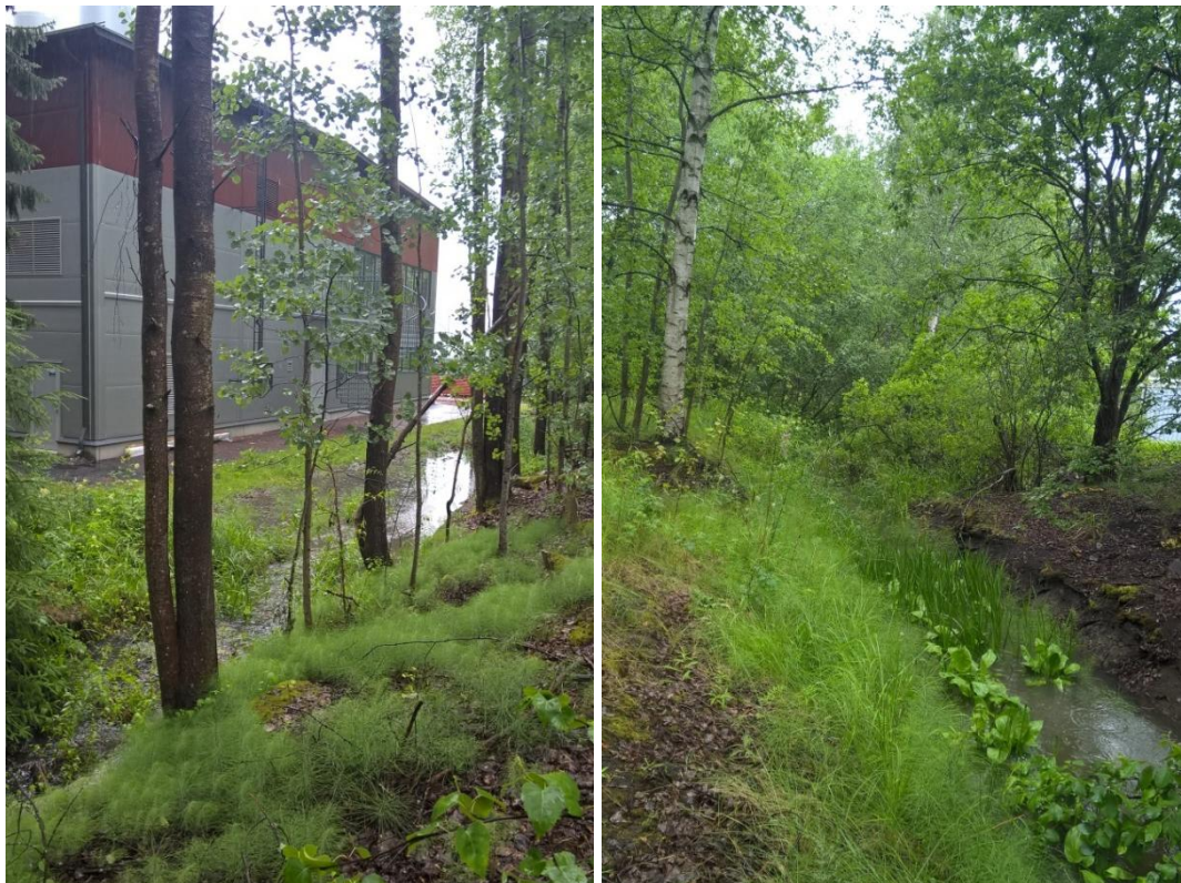
Kuva 62. a) Uoma tulvi kuntokeskuksen kohdalla uomastaan lähes kiinteistölle. b) Alempana virtauskapasiteetti on hyvä.
