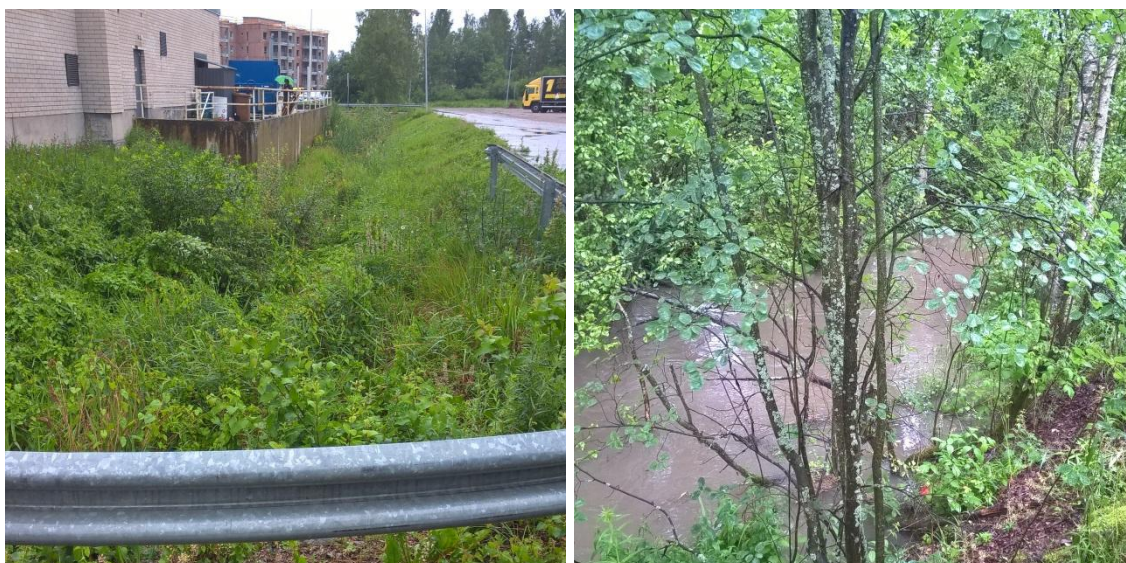
Kuva 63. a) Sivuojan linjaus kulkee huoltoaseman ja parkkipaikan välistä ja yhtyy Loutinojaan. b) Yhtymäkohdan jälkeen Loutinojan vesimäärä oli todella runsas inventointihetkellä.
