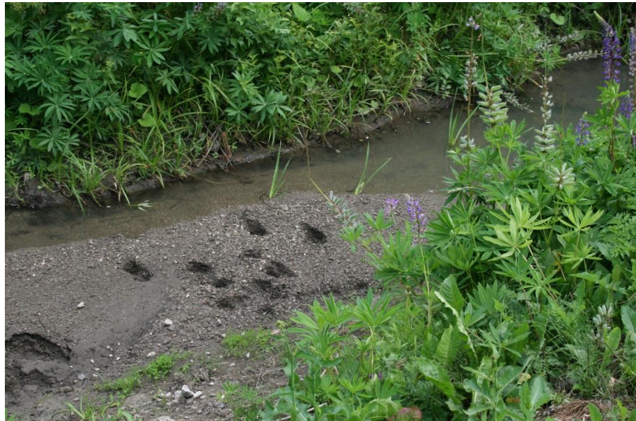
Kuva 91. Radanvarren ojaan on kertynyt huomattavasti kiintoainesta.
