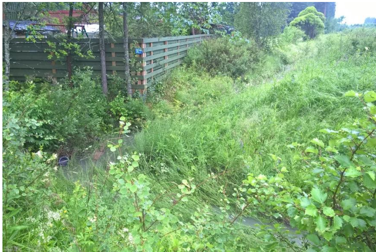
Kuva 39. Nauristie 16:n kiinteistön takanurkka on uhattuna.
